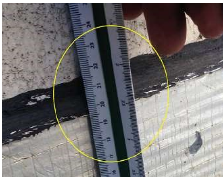
Imagem 21 – Rodapé de impermeabilização inferior a 30cm em área sem revestimento.
