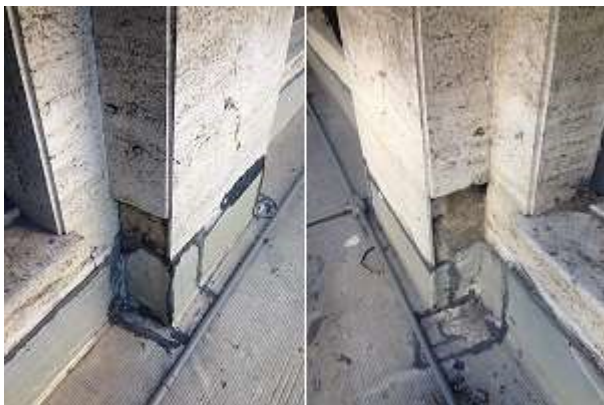
Imagem 20 – Revestimentos desprendidos da marquise 02.
